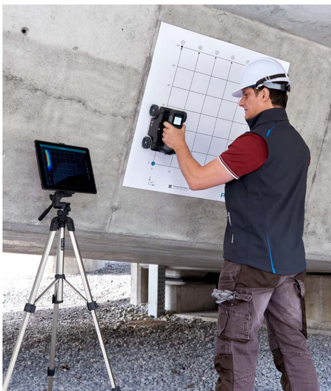
Proceq GPR Live durante l'esecuzione di area scan con l'ausilio di una griglia Proceq
