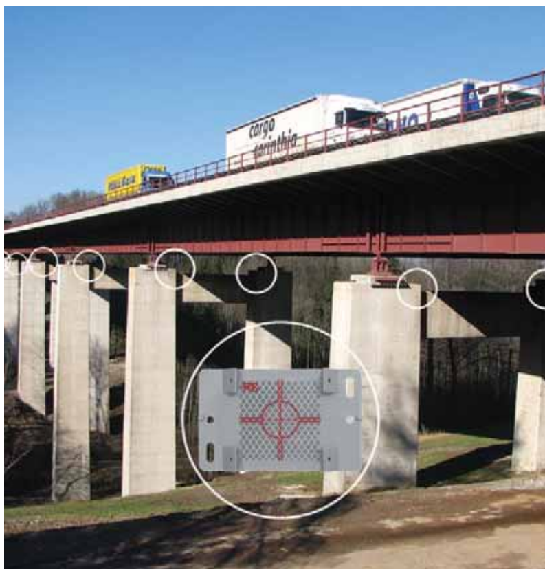
Osservazione del ponte "Loitalbrücke" con RSAKZ6
