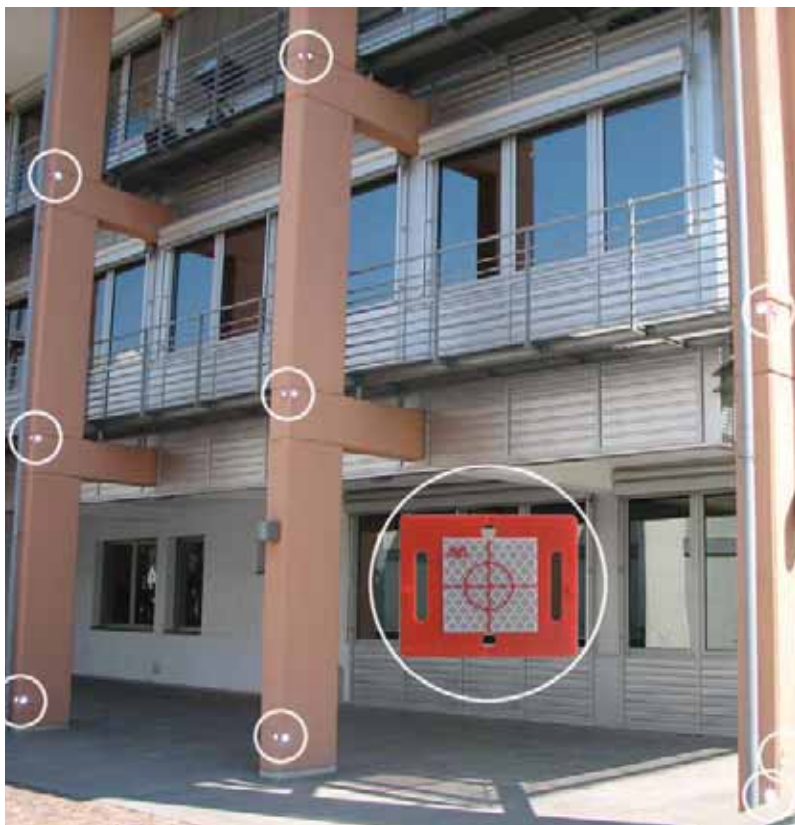
Osservazione di facciate con RS60r
