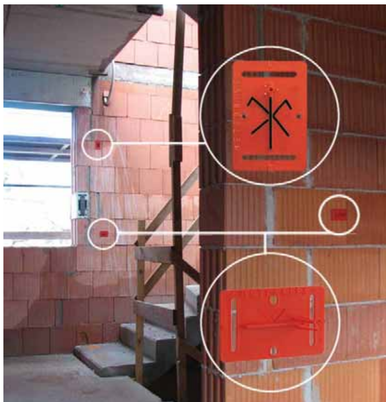
RS20r per il fissaggio della linea di livello e degli assi
