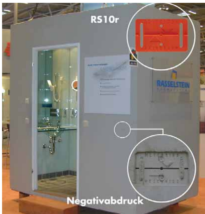
Bagno prefabbricato con impronta negativa nel calcestruzzo
