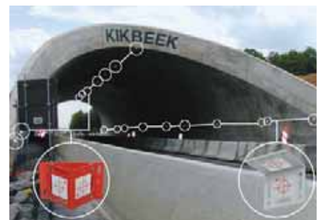
Nuova costruzione Ecluduct Belgio
