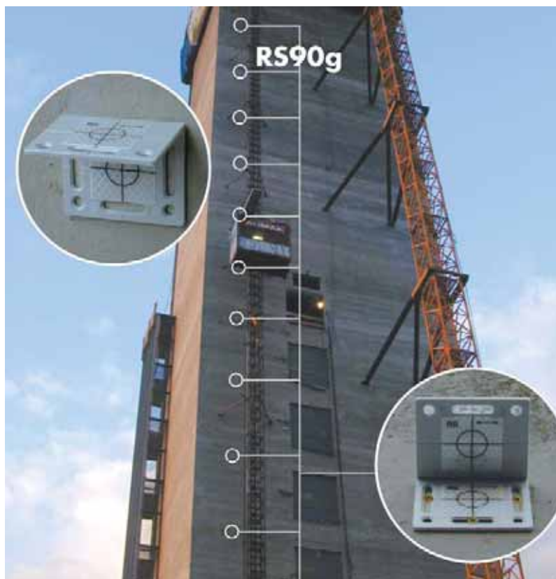
Cassaforma rampante con RS90g
